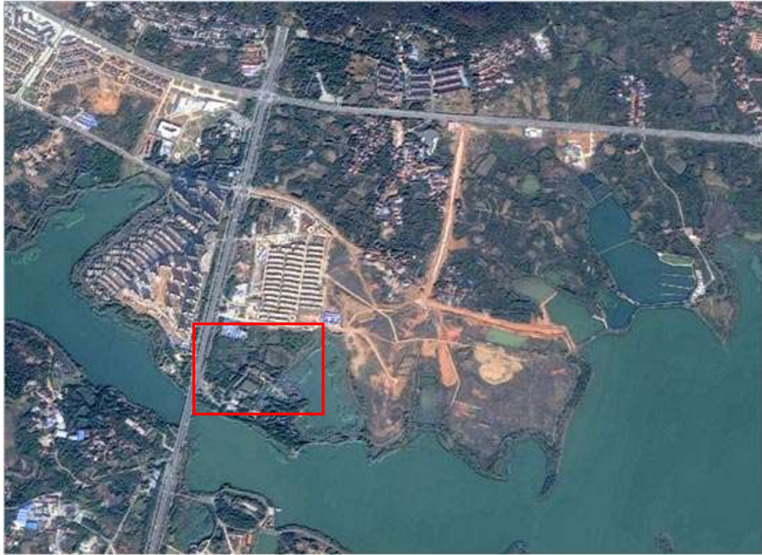
图 1 高分二号影像（2019 年 10 月 29 日）火神山医院建设前情况
